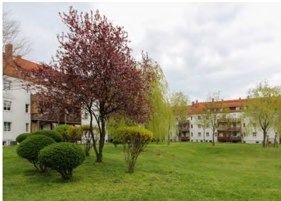
Bild 01: In den Mehrparteienhäusern in der Bernburger Straße und im Kabelweg warten sanierte 2- und 3-Raum-Wohnungen auf neue Mieter*innen. Foto: TAG Wohnen
